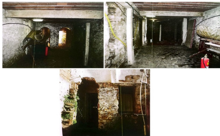
Figura 12. Vistas parciais do interior e do exterior do porão em período anterior à reforma de 2017.
