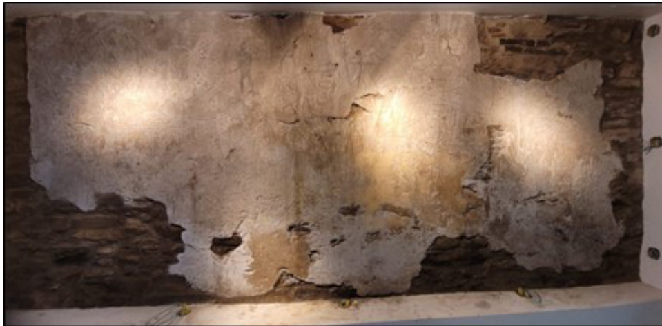
Figura 8. Acima: fotografia do mural em argamassa assentado sobre os alicerces do sobrado da Rua Direita.
