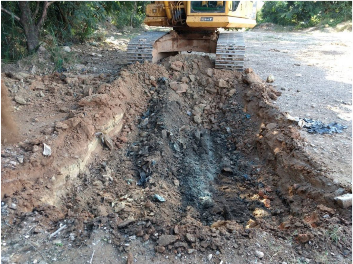
Figura 2. Fase inicial da escavação: retirada da cobertura dos resíduos.
