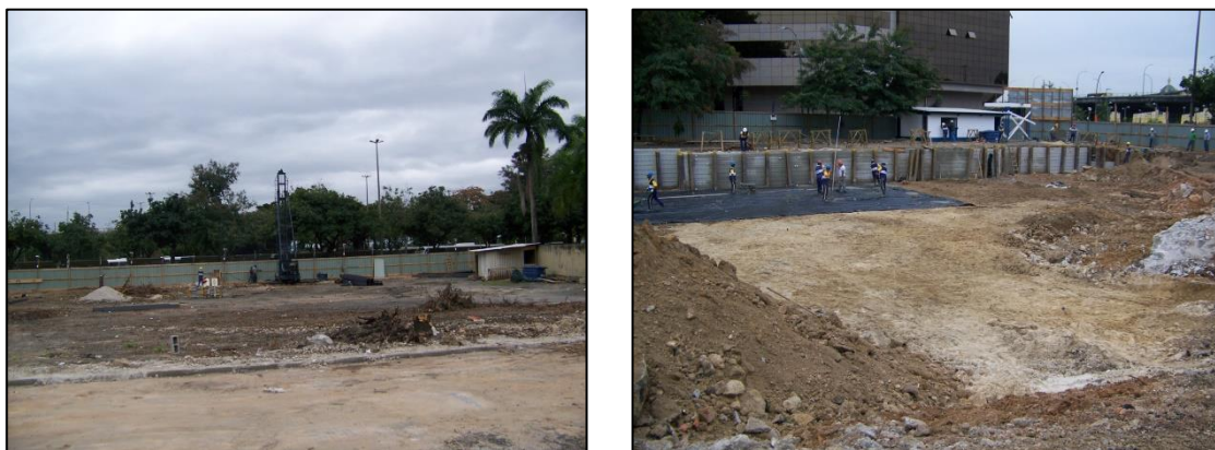
Figura 18 – A) À esquerda, o terreno do empreendimento ao se iniciarem as escavações. B) À direita, ao final dos trabalhos, a exposição das areias da antiga praia de Dom Manuel. Fotos: T. A. Lima.
